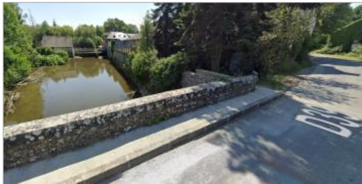
RD 39 au lieu-dit La Motte coté Saint-Armel, rive gauche
