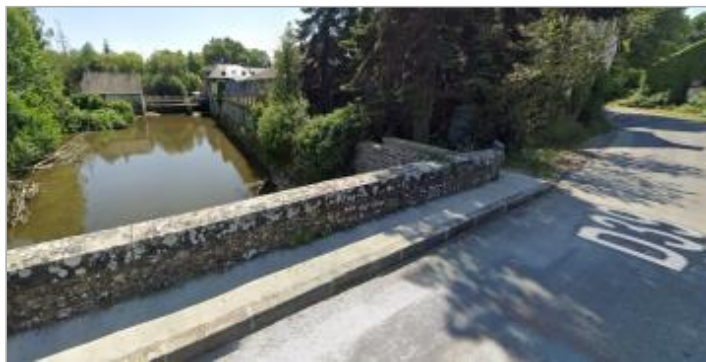
RD 39 au lieu-dit La Motte coté Saint-Armel, rive gauche
