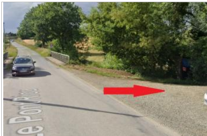
Le pont Riou à Saint Didier
