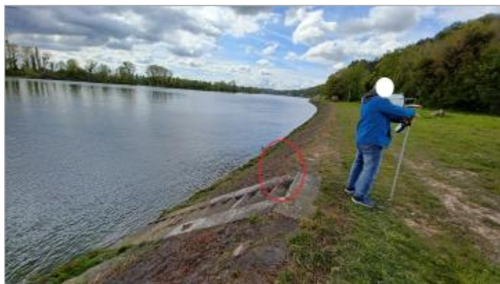
Laisse de crue sur la 1ère marche en partant du haut de l'escalier
