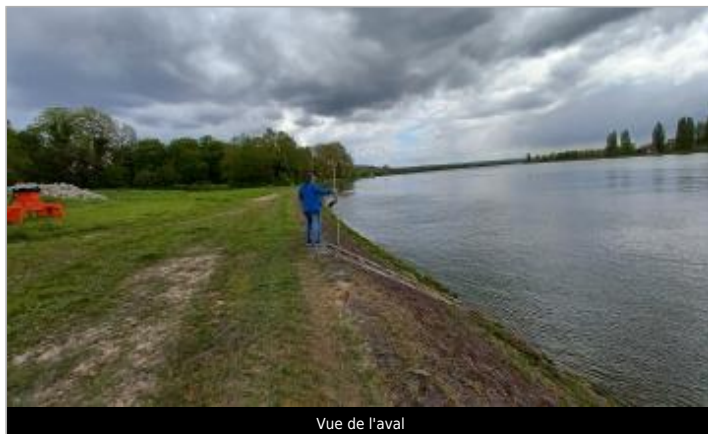
Vue de l'aval
