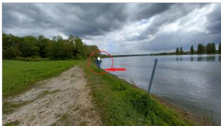
Laisse de crue au sol
