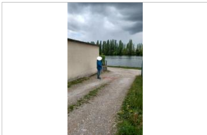
Laisse de crue au sol
