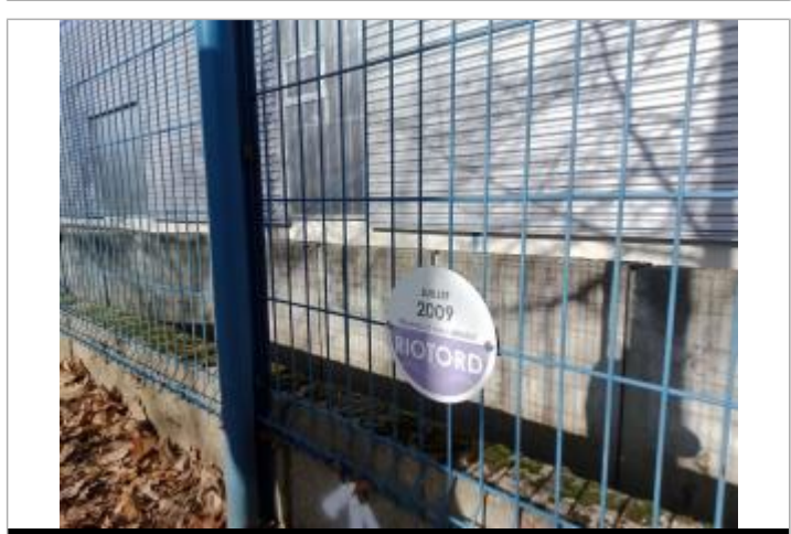
Vue du repère de crues
