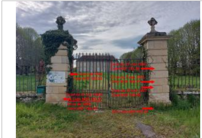
Piliers de la demeure de Mauboux en 2024
