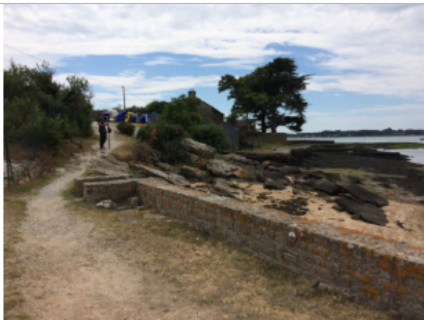
Muret du port du Parun
