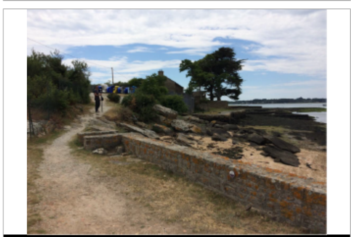
Muret du port du Parun
