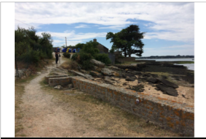
Muret port du Parun
