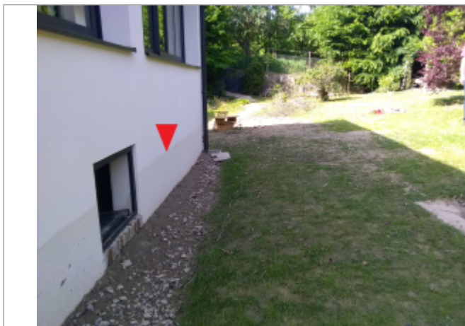
Façade arrière avec laisse visible
