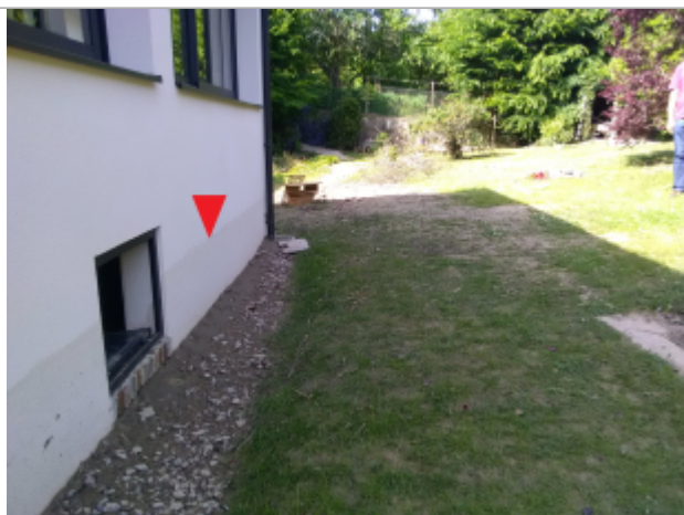
Vue globale de la façade nord
