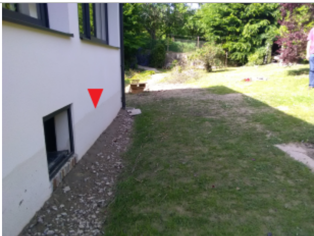
Vue globale de la façade nord
