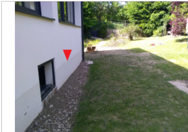
Façade arrière avec laisse visible
