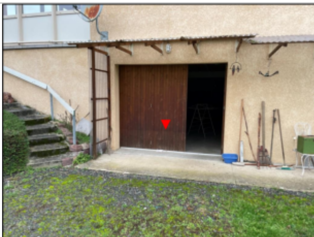
Vue de la façade avec porte de garage
