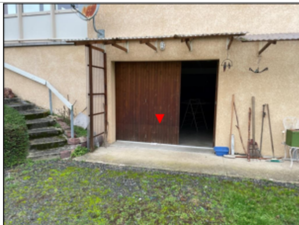
Vue globale de la façade avec porte de garage
