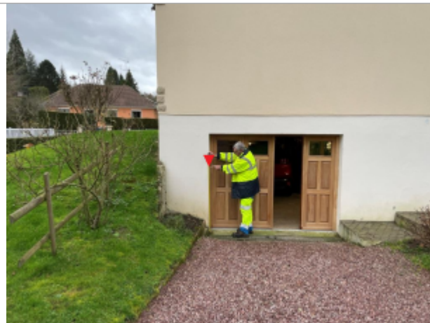
Vue de la porte de garage en sous-sol
