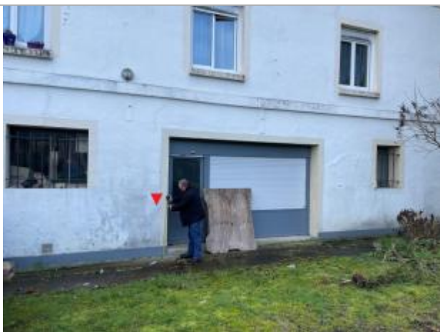
Vue globale de la façade
