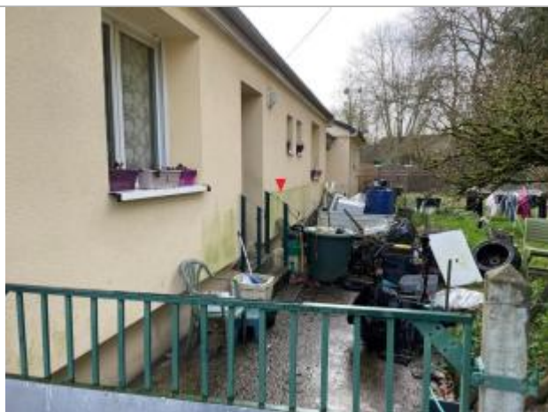
Vue globale terrasse et façade de l'habitation
