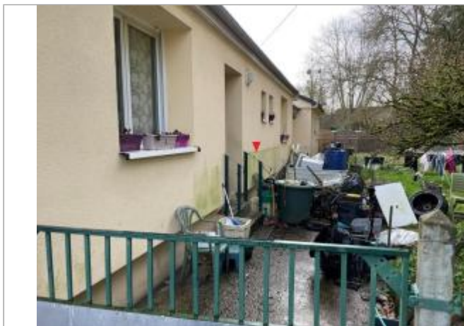
Vue d'ensemble de la terrasse et façade
