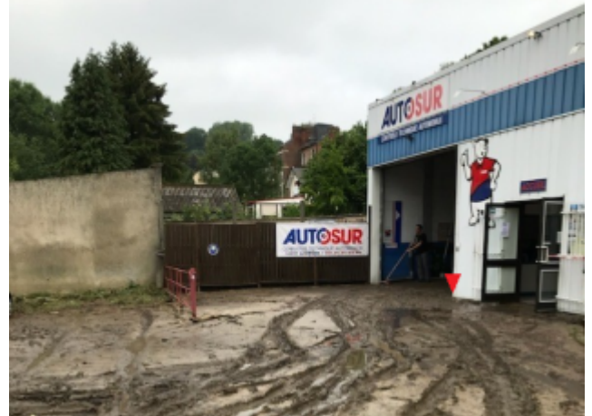
Vue d'ensemble depuis la cour de l'atelier
