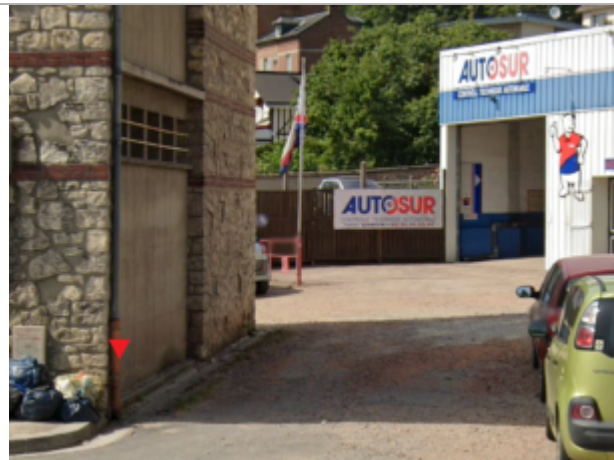
Vue d'ensemble du mur extérieur côté gauche en entrant dans la cour
