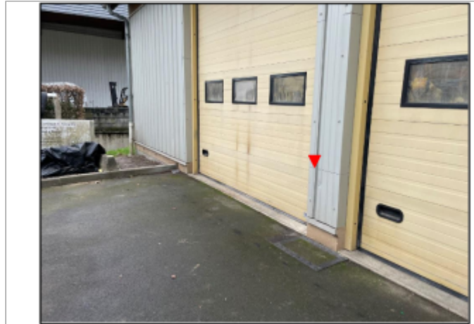
Vue d'ensemble du site, cour des services techniques
