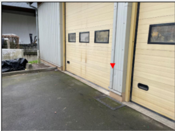
Vue d'ensemble depuis la cour des services techniques
