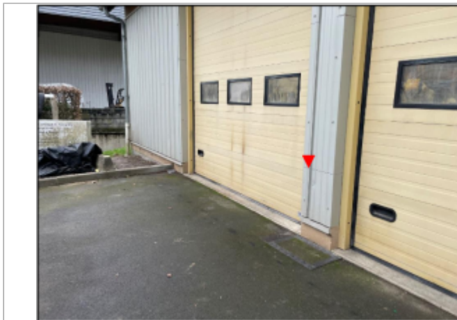
Vue d'ensemble du site, cour des services techniques
