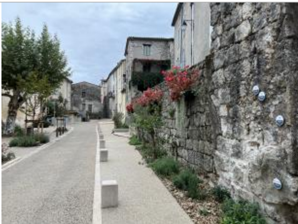
repères sur mur
