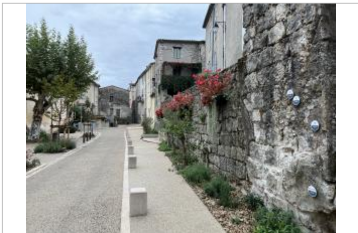
mur d'enceinte avec plusieurs repères
