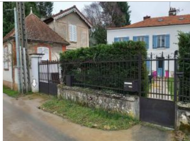
Maison d'habitation - Mesure effectuée au niveau du portail (Poteau béton gauche)
