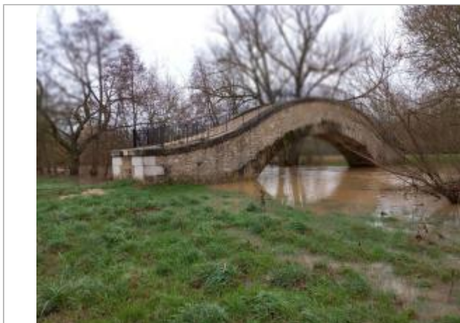
Aqueduc de la Dhuis - Franchissement Grand Morin
