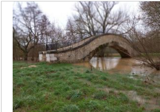
Aqueduc de la Dhuis - Franchissement Grand Morin
