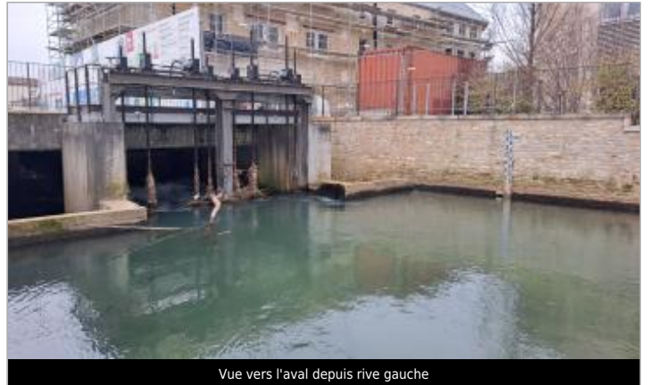
Vue vers l'aval depuis rive gauche
