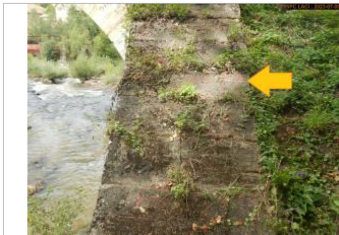
Vue du repère en 2023
