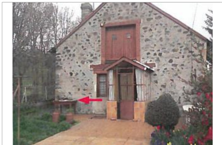
Vue du repère en 2023
