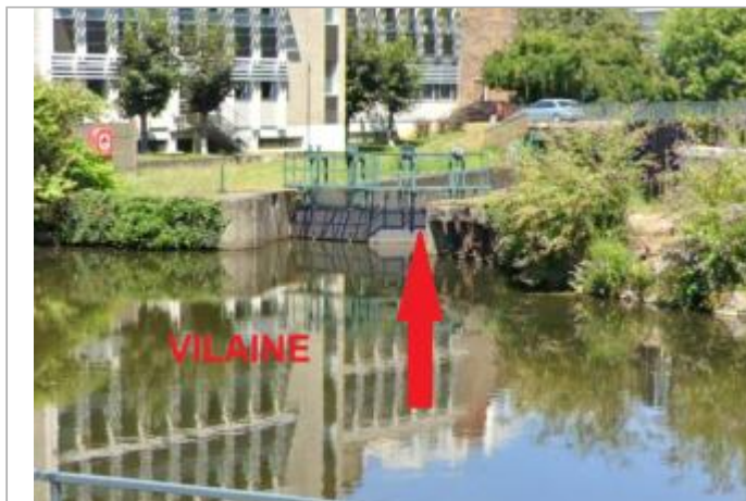
Porte aval de l'écluse du pont des Loges
