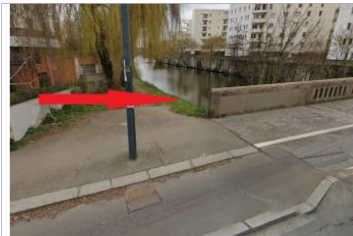
Amont pont Laennec sur le bras gauche de la Vilaine
