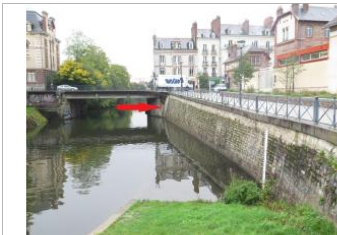
Amont pont Laennec sur le bras droit de la Vilaine
