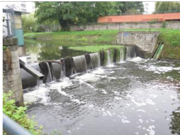
Aval maçonnerie du clapet du cabinet vert
