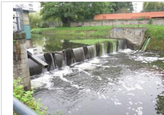
Aval maçonnerie du clapet du cabinet vert
