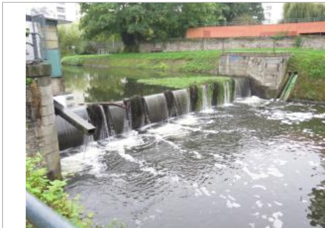
Aval maçonnerie du clapet du cabinet vert
