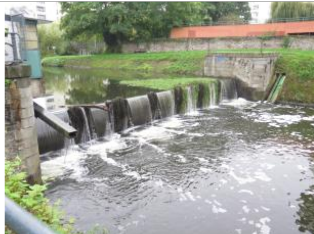
Aval maçonnerie du clapet du cabinet vert
