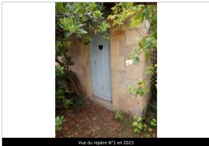
Vue du repère N°1 en 2023
