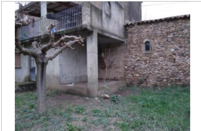
Mur sous la terrasse
