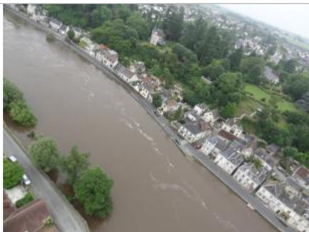
Vue de la photo en 2016 (vue drone)
