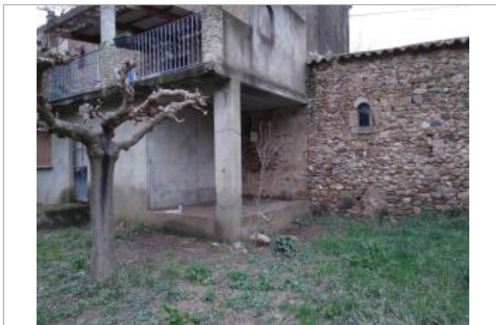
Mur sous la terrasse
