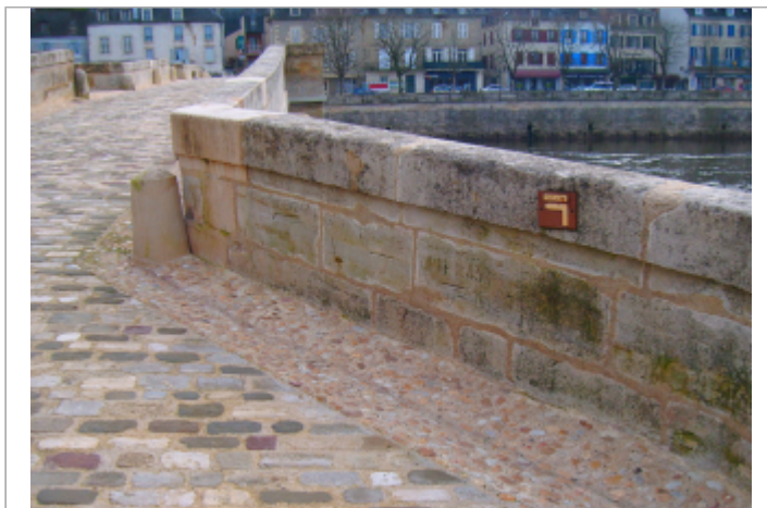
Vue du site - source : mairie de Terrasson
