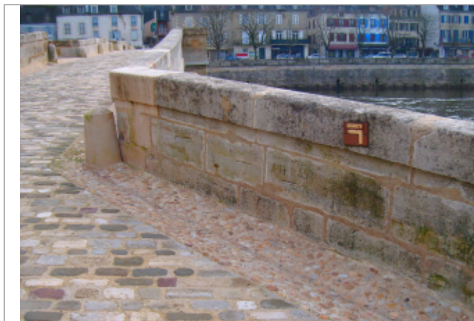
Vue du site - source : mairie de Terrasson
