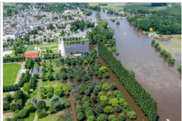
Vue de la photo en juin 2016 (après le pic de crue)
