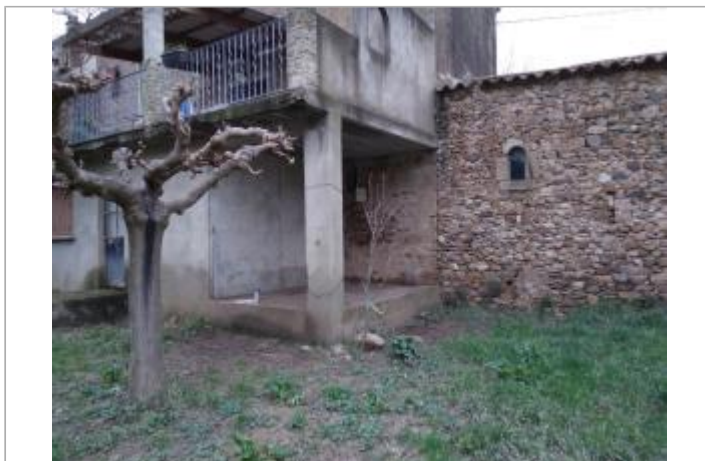
Mur sous la terrasse
