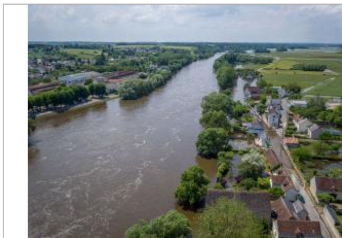
Vue de la photo en juin 2016 (après le pic de crue)
