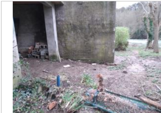
Colonne de terrasse
