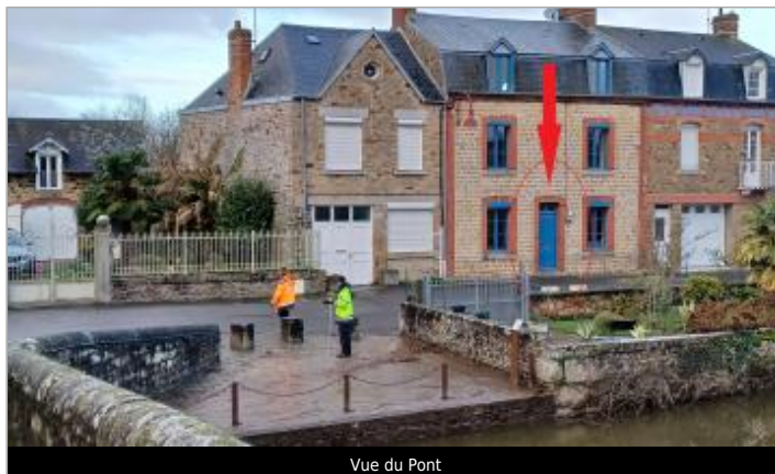
Vue du Pont
