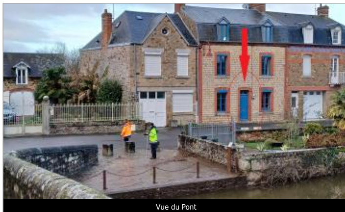
Vue du Pont
