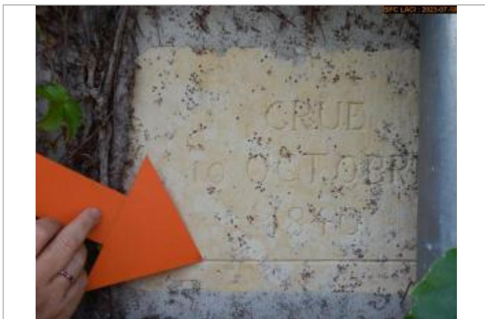
Vue du repère de crue en 2023
