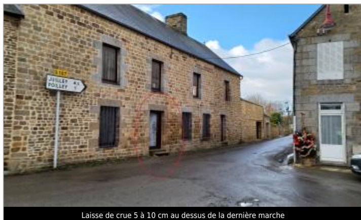
Laisse de crue 5 à 10 cm au dessus de la dernière marche
