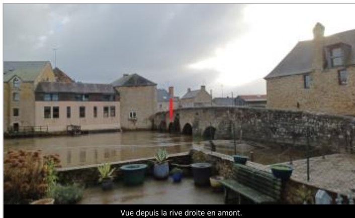
Vue depuis la rive droite en amont.
