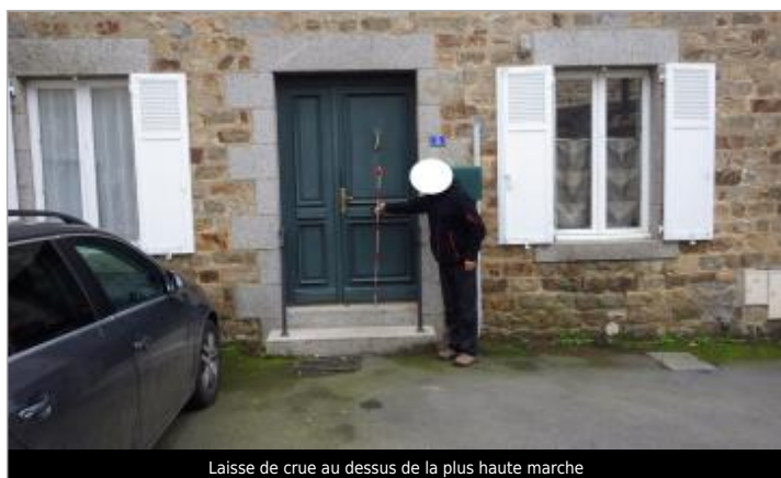
Laisse de crue au dessus de la plus haute marche
