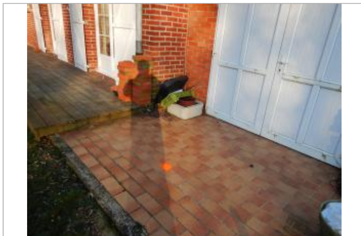
Nivellement à ras du sol.
