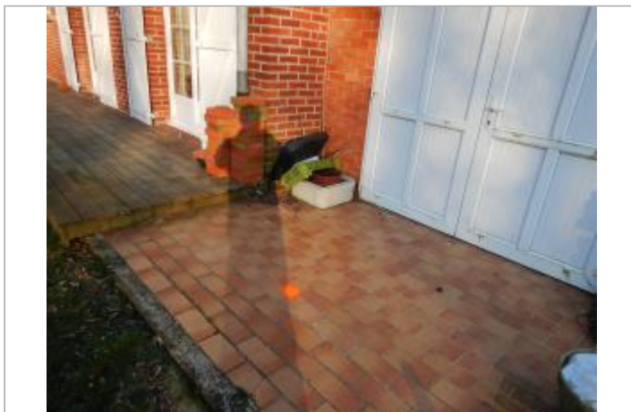
Nivellement à ras du sol.
