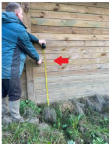
Photo de la mesure sur le bardage bois du local
