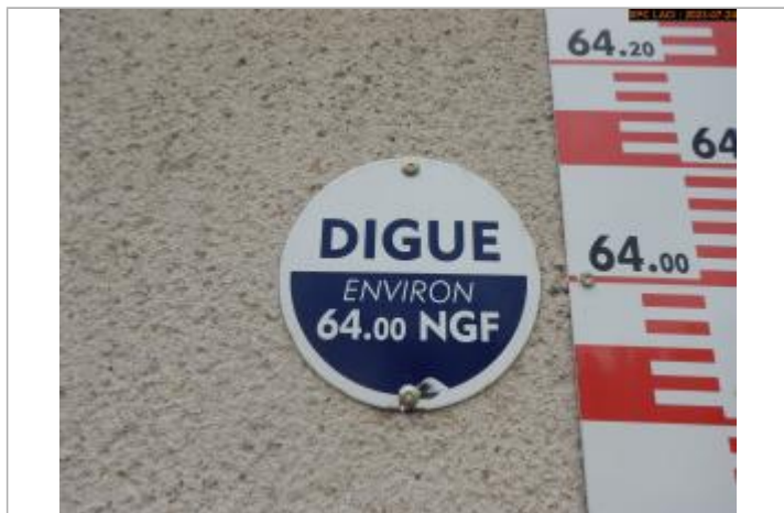
Vue du repère Digue en 2023
